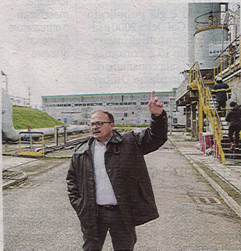
Federico Montanari (Ifm) mostra l'impianto di trattamento acque Tas del quale è previsto il rewamping
