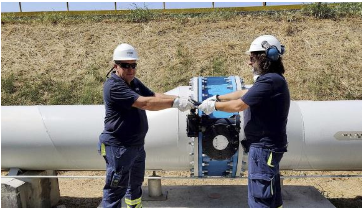
Tecnici al lavoro nell'impianto di depurazione del petrolchimico
