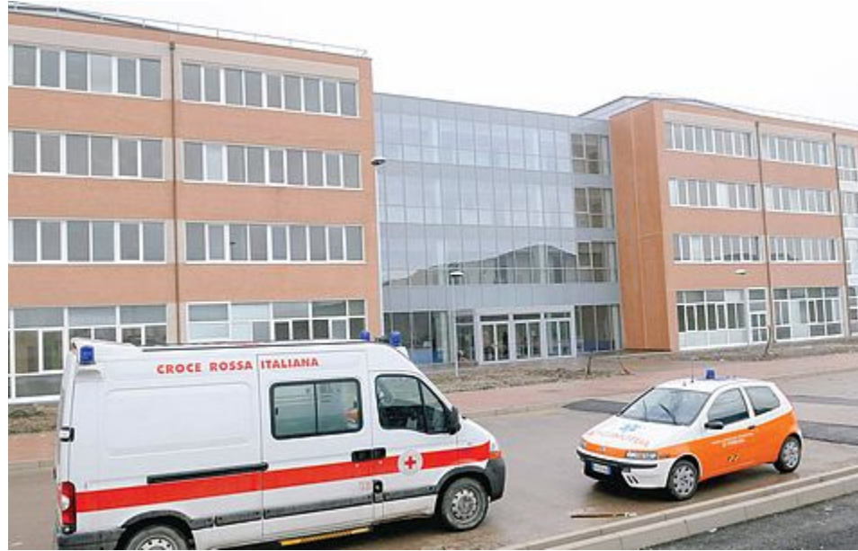
La causa, promossa da Progeste e Coopser, riguarda i servizi ‘no core’ dell’ospedale
